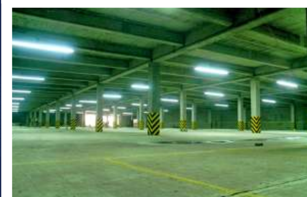
Qatar Condominio. Diseño estructural y Construcción de Edificio. Construcción Sistema Postensado en estructura. Vivienda - Bucaramanga. Propietario: OTECO LTDA Área: 12.500 m 2
